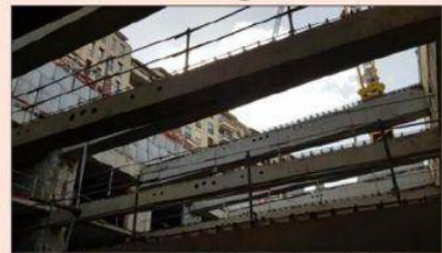
Les imprévus se sont succédé tout au long du chantier. Photo Progrès/Aline DURET
