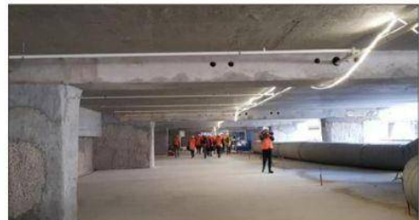
Visite de chantier du futur parking Saint-Antoine. Photo Progrès/A. D.
