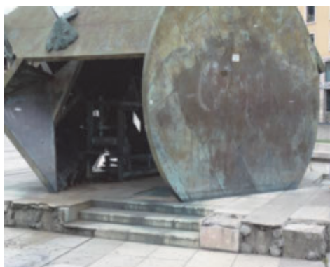
Place Louis Pradel : que penserait Ipousteguy du soin apporté à ses œuvres ?
