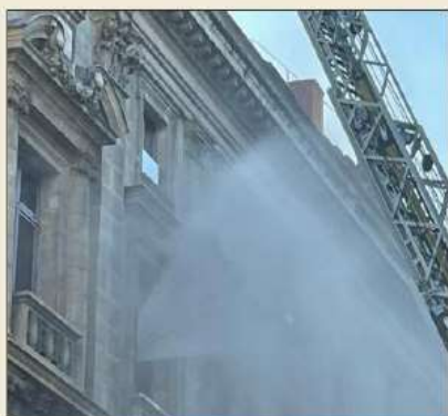
Le feu serait sorti de la machinerie d'ascenseur.
