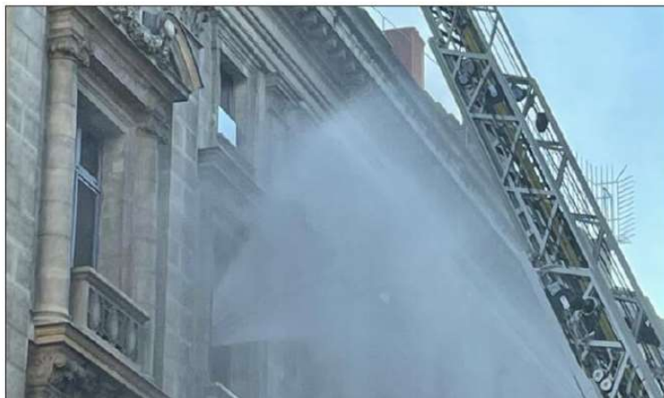
La technique d'hydro-ventilation a été mise en œuvre afin de permettre l'évacuation des fumées dans les différents niveaux du théâtre. Photo Progrès/Michel NIELLY
