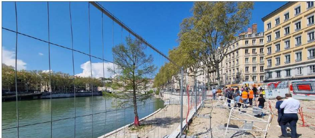
Sur cette emprise se trouvait autrefois le parking Saint-Antoine, aujourd'hui démolé. Photo Progrès/Aline DURET
