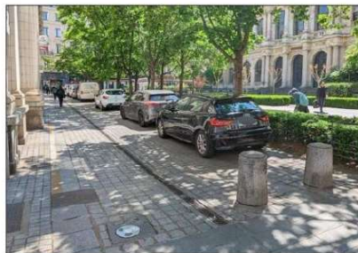
Au nord du palais de la Bourse, une borne défectueuse transforme l'espace piétonnier en lieu de stationnement sauvage.
