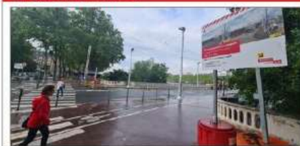
Les travaux vont se terminer fin août. Photo/David TAPISSIER
