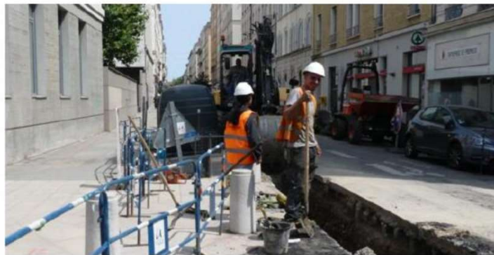
Anthony, technicien et Sreyka, élève ingénieure en formation, sur le chantier. Photo Jean Garavel
