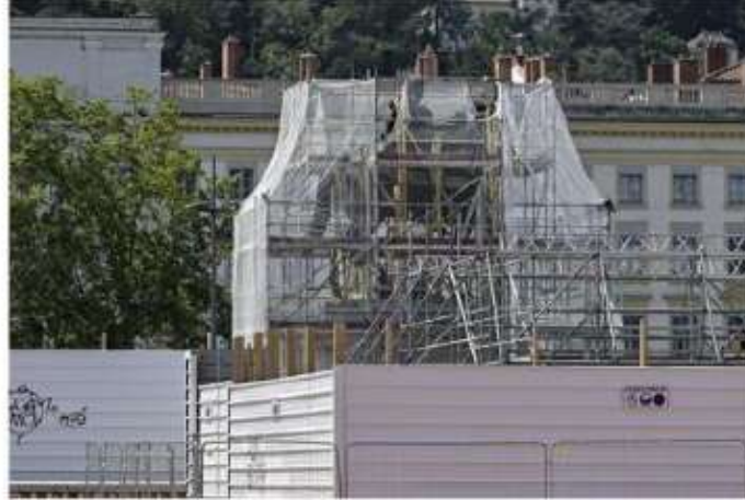
Le chantier de restauration de la statue de Louis XIV, place Bellecour à Lyon, a été lancé en mai dernier. Photo Maxime Jegat
