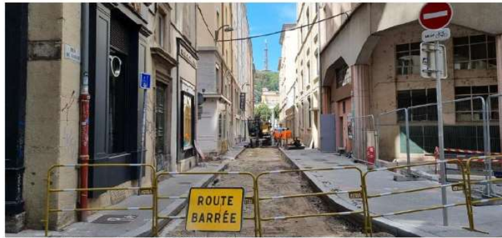
Les travaux de réseaux sont engagés cet été dans la Presqu'île. Photo Aline Duret
