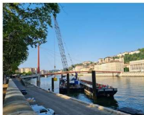
La déconstruction de l'ancien parking Saint-Antoine achevée début 2022, s'est effectuée par voies navigables. Photo Nadine Micholin
