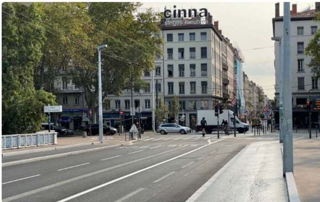
Une voie de circulation automobile a été retirée pour permettre la création des deux voies cyclables sur trottoir.
