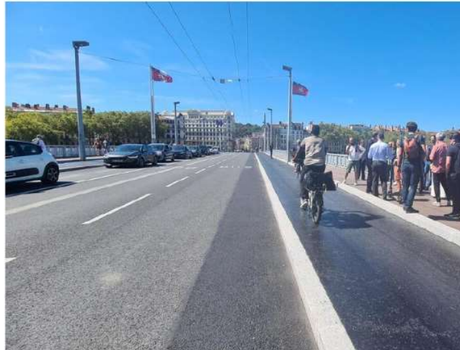
La remise en circulation ce jeudi du pont Lafayette fait l'unanimité. Même si certains petits détails restent à peaufiner. Photo David Tapissier
