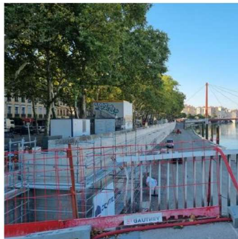
L'escalier d'accès est en cours d'aménagement côté Sud du pont Maréchal Juin. Photo Nadine Micholin
