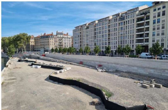
Au nord du pont Maréchal Juin, la construction quai bas de la terrasse intermédiaire et de la promenade piétonne est plus avancée que la partie sud. Photo Nadine Micholin
