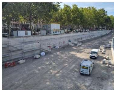
Au Sud du pont Maréchal Juin, les travaux pour la promenade et la terrasse intermédiaire sont moins avancés. Photo Nadine Micholin
