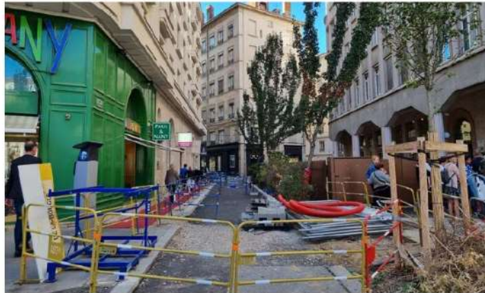
Le chantier de la rue Jean Fabre devant l'école élémentaire Lamartine, est à l'arrêt. En revanche, on aperçoit la nouvelle cour agrandie et la palissade neuve contre laquelle, la végétation et les arbres existants ont été conservés. Photo Nadine Micholin
