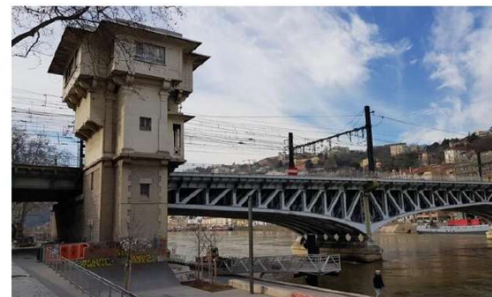
Le poste d'aiguillage a été mis en service en 1930. L'ouvrage s'élève à 20 mètres de haut. Photo Aline Duret
