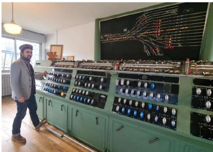
Olivier Vellay, architecte du patrimoine, présente le poste d'aiguillage et son écran de contrôle. Photo David Tapissier
