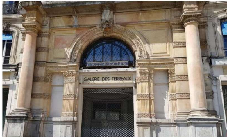
La Ville de Lyon, aujourd'hui propriétaire du lieu, va poursuivre des occupations temporaires durant les travaux. Photo Arnélia Simier
