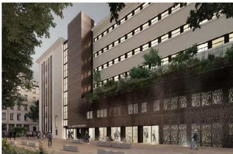
Visuel du Lycée Juliette Récamier, côté rue de la Charité avec la création d'un ascenseur à l'entrée au N°57, un parvis spacieux, un jardin suspendu et la pose d'une tôle perforée verticale devant les fenêtres qui habillera l'extension sur deux niveaux (rez-de-chaussée et 1 er étage). Photo Archigroup Design Et Réalisation
