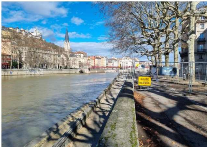
L'accès côté sud est encore interdit à la promenade sur la portion basse du quai Tilsitt, le long de la Saône, du n° 16 à hauteur de la passerelle Saint-Georges jusqu'au n° 21.
