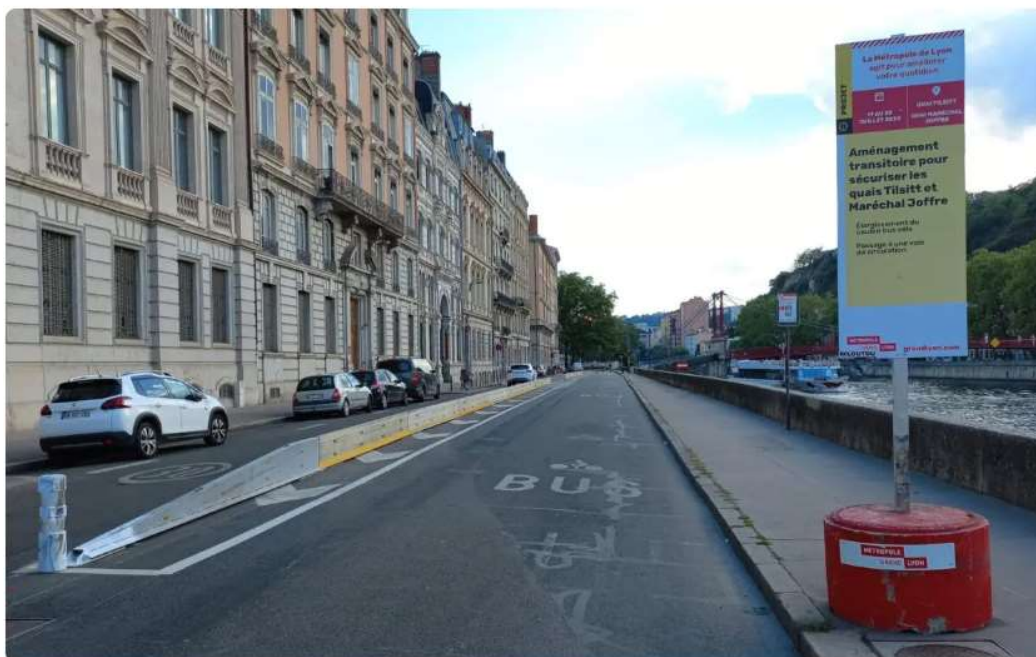
Un rail de sécurité est désormais installé sur les quais Tilsitt et Maréchal Joffre, séparant la voie réservée aux bus et modes doux de celle des automobilistes, qui ont perdu une voie de circulation. (Crédit Fabien Bagnon – Twitter)
