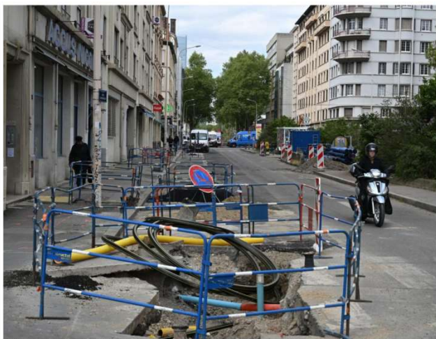
Des travaux sont en cours rue Garibaldi, notamment près de la rue Rachais. Sur de nombreux autres points, à Lyon, il faut s'armer de patience pour circuler. Réductions de chaussée, interdictions de rouler, routes coupées : on vous dit tout sur les axes concernés et à quoi il faut s'attendre. Photo : Frédéric Chauvier/Pixie 9
