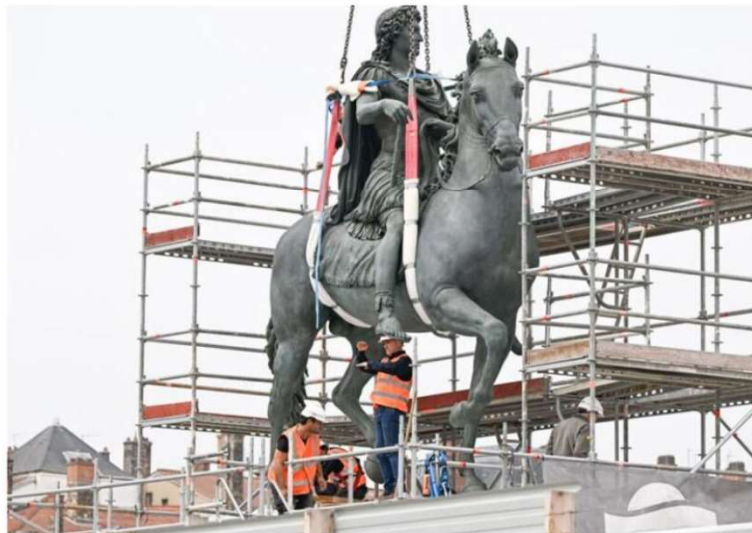
Après neuf mois de travaux, la statue de Louis XIV de la place Bellecour, totalement restaurée, a réintégré son socle historique, lui aussi nettoyé et réparé. Photo Joël Philippon
