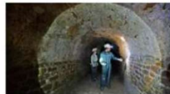
Au cœur d'une galerie souterraine du réseau lyonnais des Arêtes de poisson. Photo archives Richard Mouillaud
