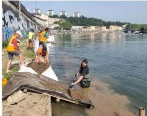
À droite dans l'eau, le gabiodiv en construction, à gauche le chemin de halage dont le sol est progressivement rendu perméable et où les arbres et plantes locales retrouvent une raison d'exister. Photo David Tapissier
