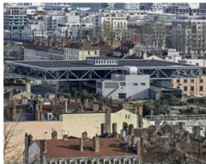
Le centre d'échange multimodal de Perrache. Photo M. Jegat
