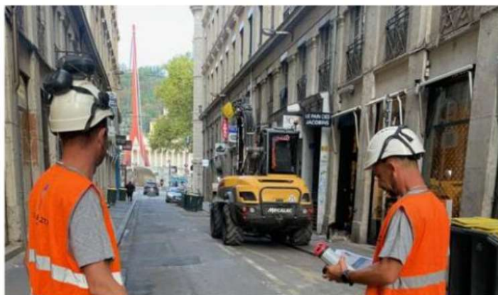
Le chantier a débuté. Photo Michel Nielly
