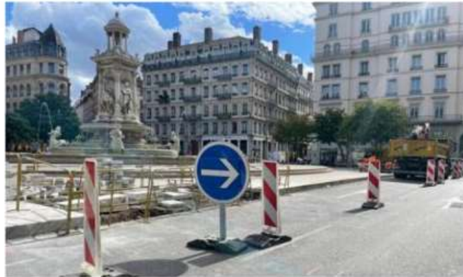
Côté ouest, deux passages piétons en construction. Photo Michel Nielly
