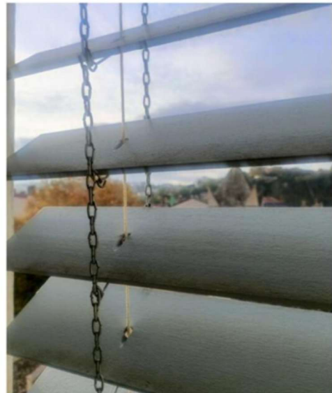
Une jalousie lyonnaise peinte dans le gris standard réclamé par les architectes des bâtiments de France, dans la Presqu'île lyonnaise. Photo Sophie Majou
