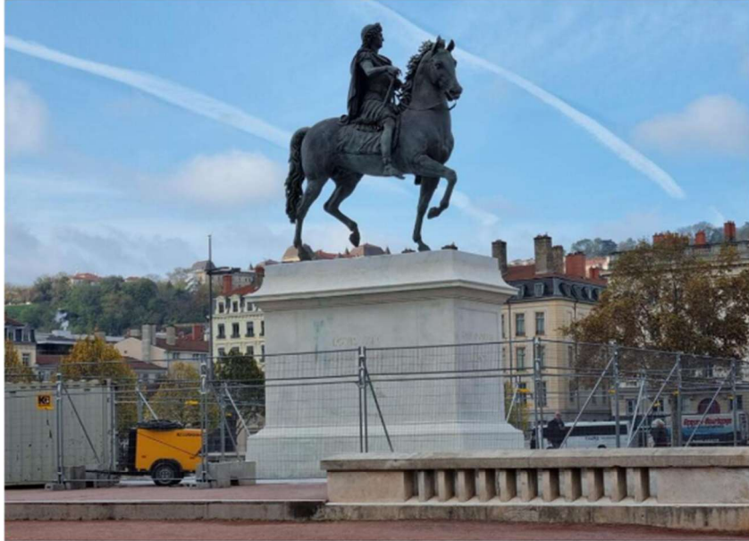
Le grillage installé en juin dernier est toujours là. Des travaux ont été engagés sur les dalles situées au pied de la statue.
