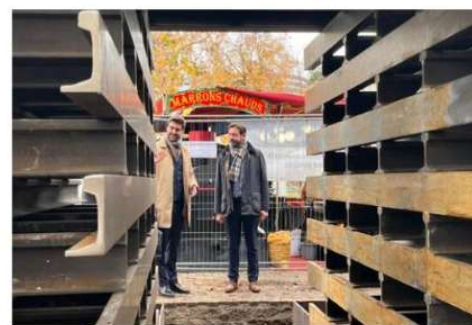
Fabrice Pannekoucke a visité le chantier. Photo Tatiana Vazquez
