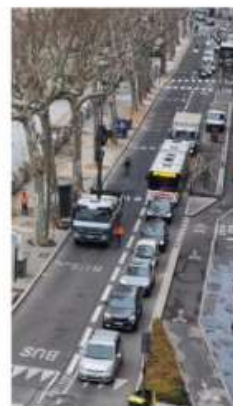
Le quai Saint-Antoine est toujours en travaux. Ici sur la partie haute du quai. Photo Aline Duret
