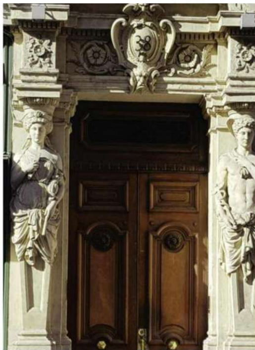
Au 38 de la rue Édouard Herriot, deux statues gainées, réalisées par Joseph-Hugues Fabish, encadrent la porte d'entrée d'un immeuble dont le propriétaire commanditaire affiche sa réussite dans le domaine de la toile tissée.
