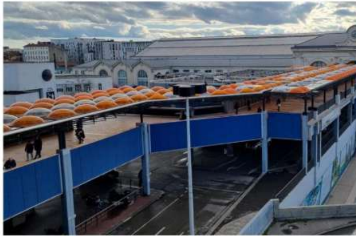
La passerelle reliant la gare au centre d'échanges va être démolie. Photo Aline Duret
