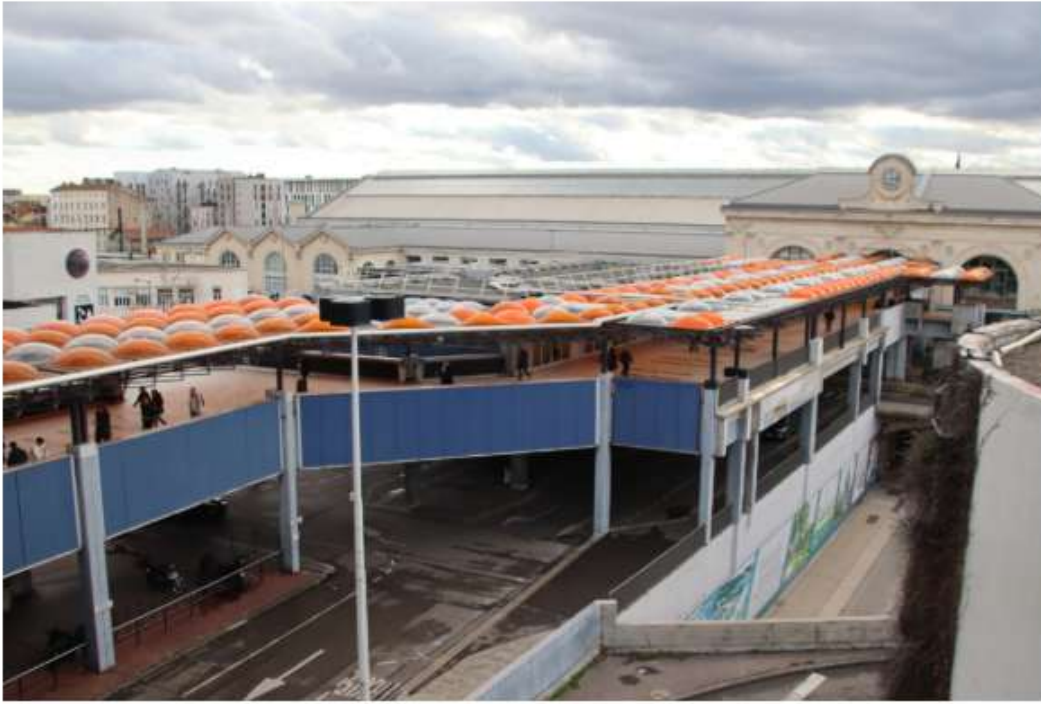
Cette passerelle sera détruite de février à septembre 2025 dans le cadre de la première phase de la métamorphose du centre d'échanges de Lyon-Perrache. (©Théo Zuili / actu Lyon)
