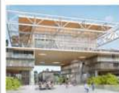
Vue du projet depuis la place Carnot. Visuel DFA - Dietmar Feichtinger Architects
