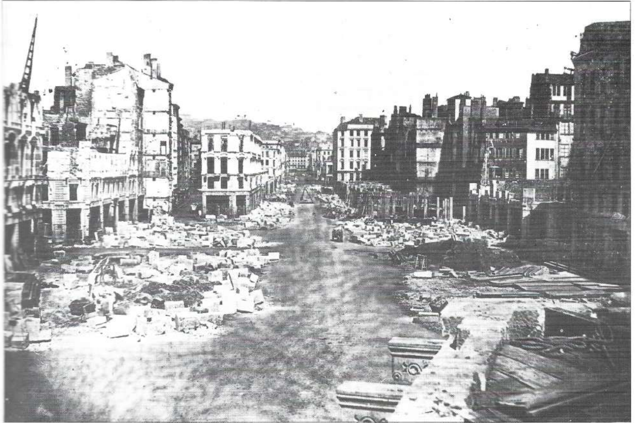
Le chantier de la rue Impériale en 1856, reproduction d'un tirage d'époque conservé aux Archives Municipales de Lyon
