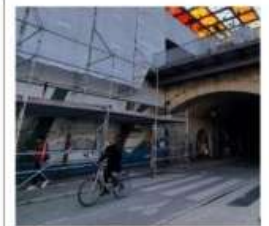
Derrière ce mur recouvert d'un échafaudage se trouve la passerelle. Photo Aline Duret
