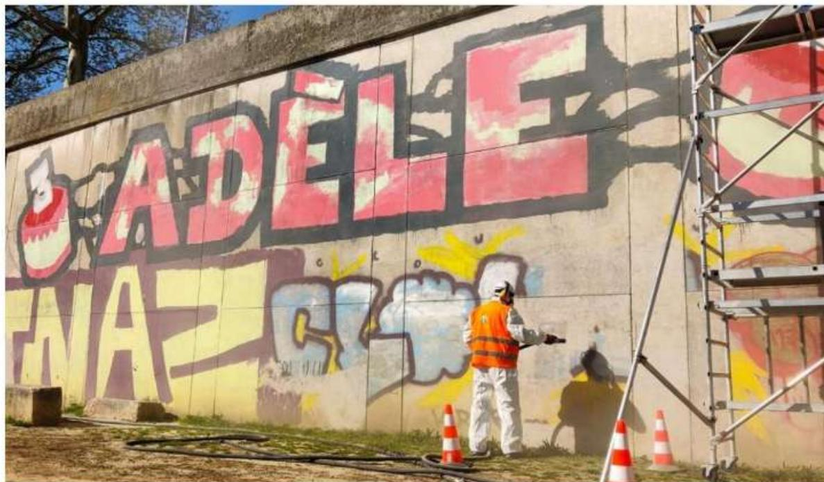
Démonstration de nettoyage d'un mur de soutènement par projection de sable sur le bas port du quai Hippolyte-Jaÿr (9<sup>e</sup>) réalisée par l'entreprise TV Net. Photo Rémi Liogier
