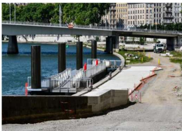
La halte fluviale, quai Saint-Antoine devrait être mise en service le 18 juin. Le ponton est déjà en place.
