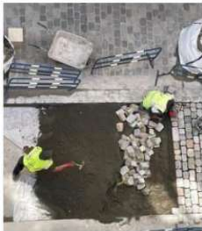
Terrassement, pavage et jointoiement.
