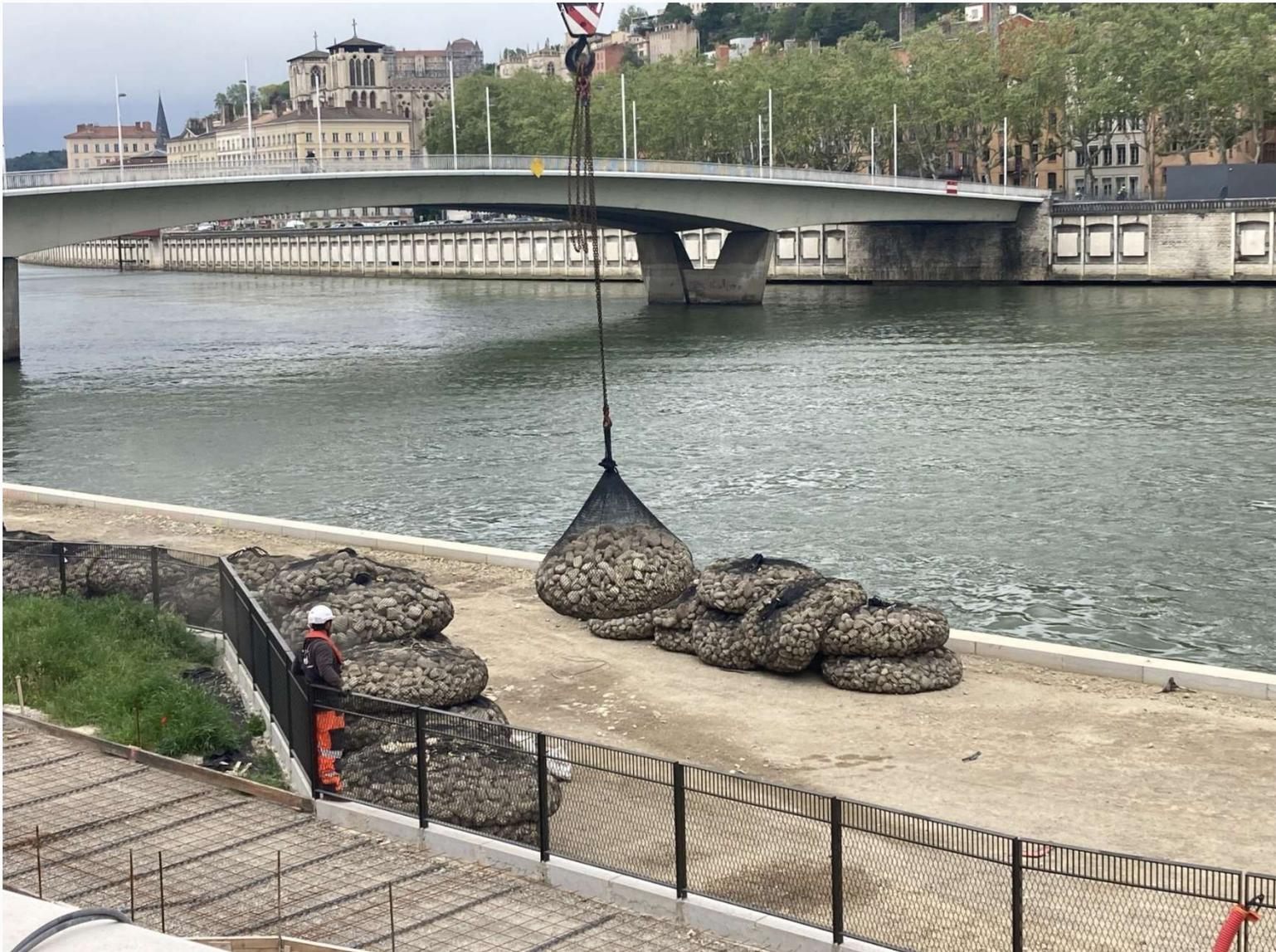
© Tony Fonteneau. - L'affouillement avait été comblé grâce au béton coulé et coffré à l'aide de sac de cailloux.
