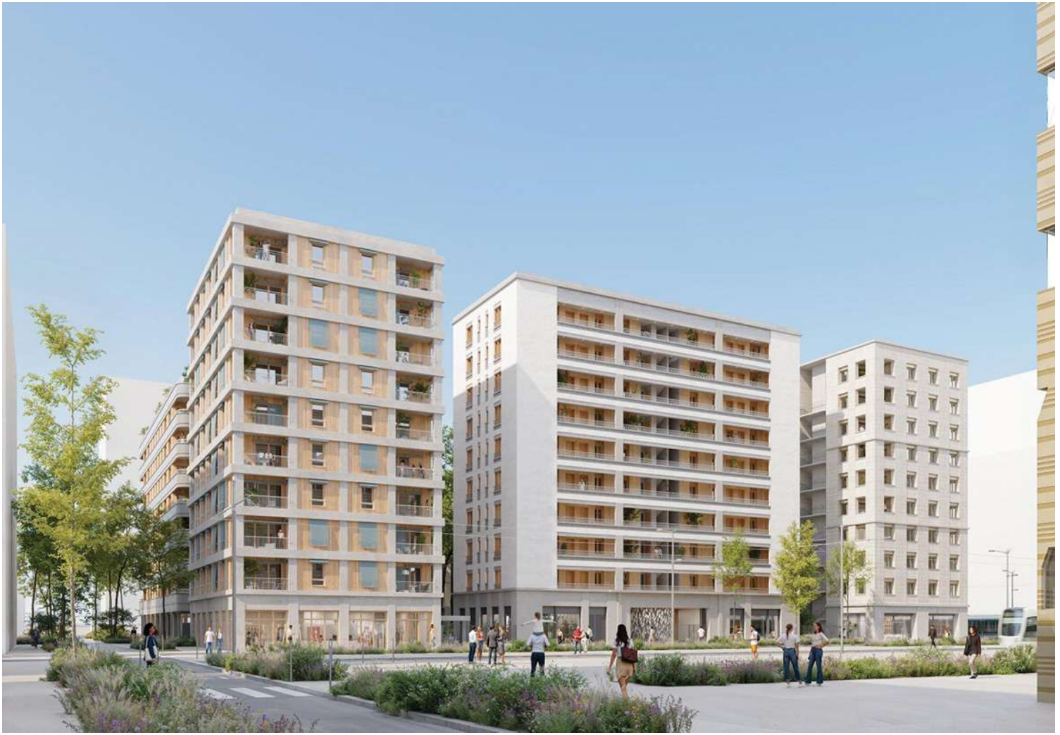
Résidence Zéphyr, en chantier début 2026 à la Confluence
