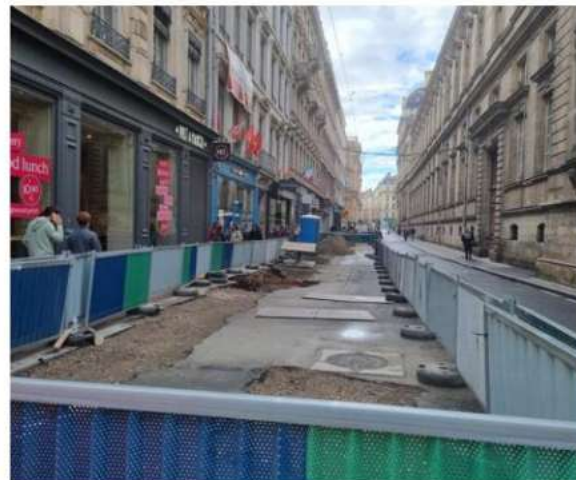
Rue Joseph-Serlin: des travaux visant à rénover les réseaux d'assainissement et d'eau potable ont démarré il y a un mois. Photo Aline Duret
