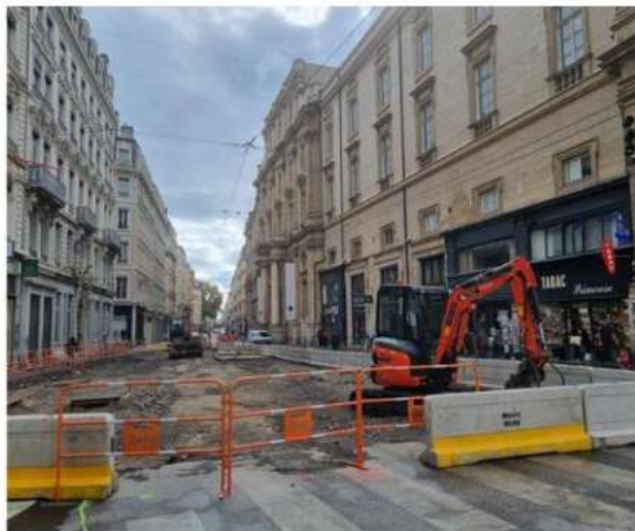
Rue Edouard-Herriot, à hauteur de la rue Joseph-Serlin : la première phase de l'aménagement a commencé. Photo Aline Duret
