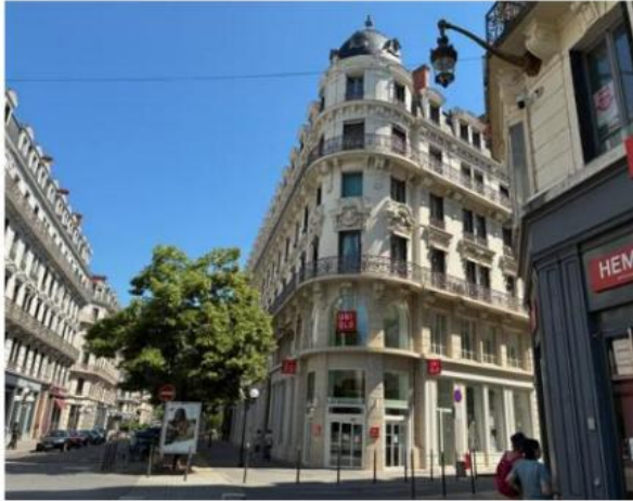
Le bâtiment Uniqlo du 2 e arrondissement ferme à cause d'une trop forte température. Photo Michel Nielly
