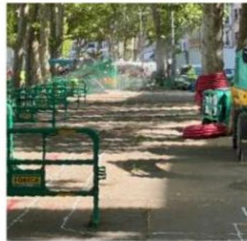
La première phase des travaux a débuté le 21 mai.
