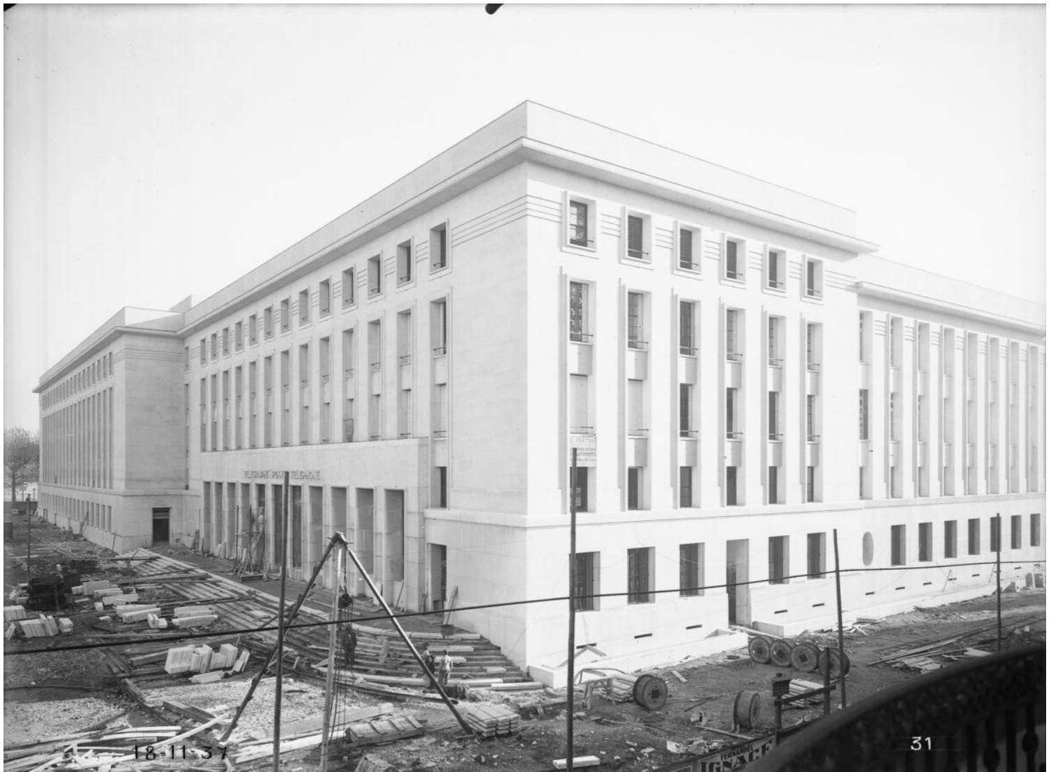
Construction Hotel des Postes, Télégraphes et Téléphonies de Lyon en 1937. ©BM de Lyon
