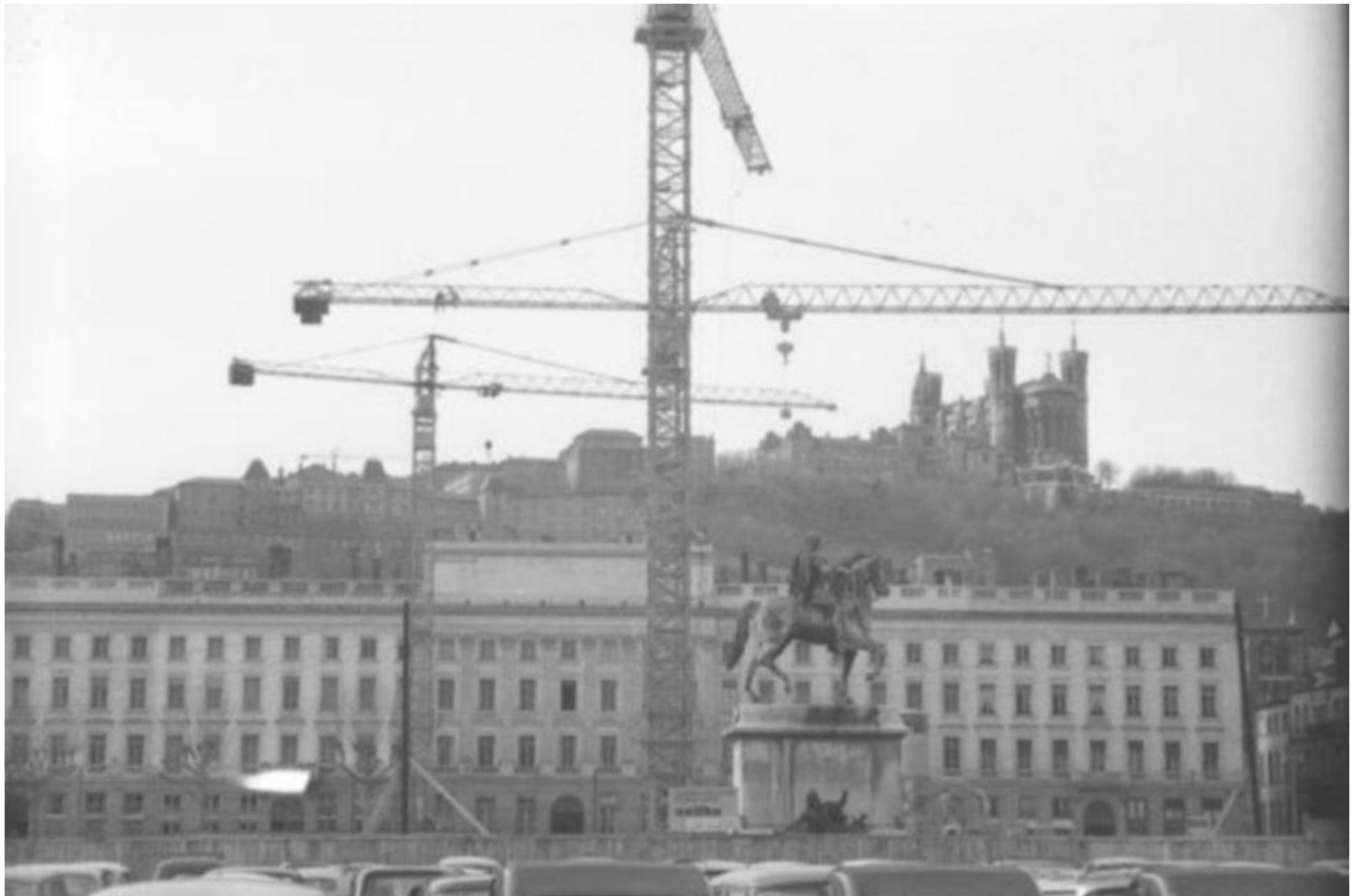
Le chantier du parking souterrain de la place Bellecour. (©Wikimedia/ Bibliothèque municipale de Lyon)
