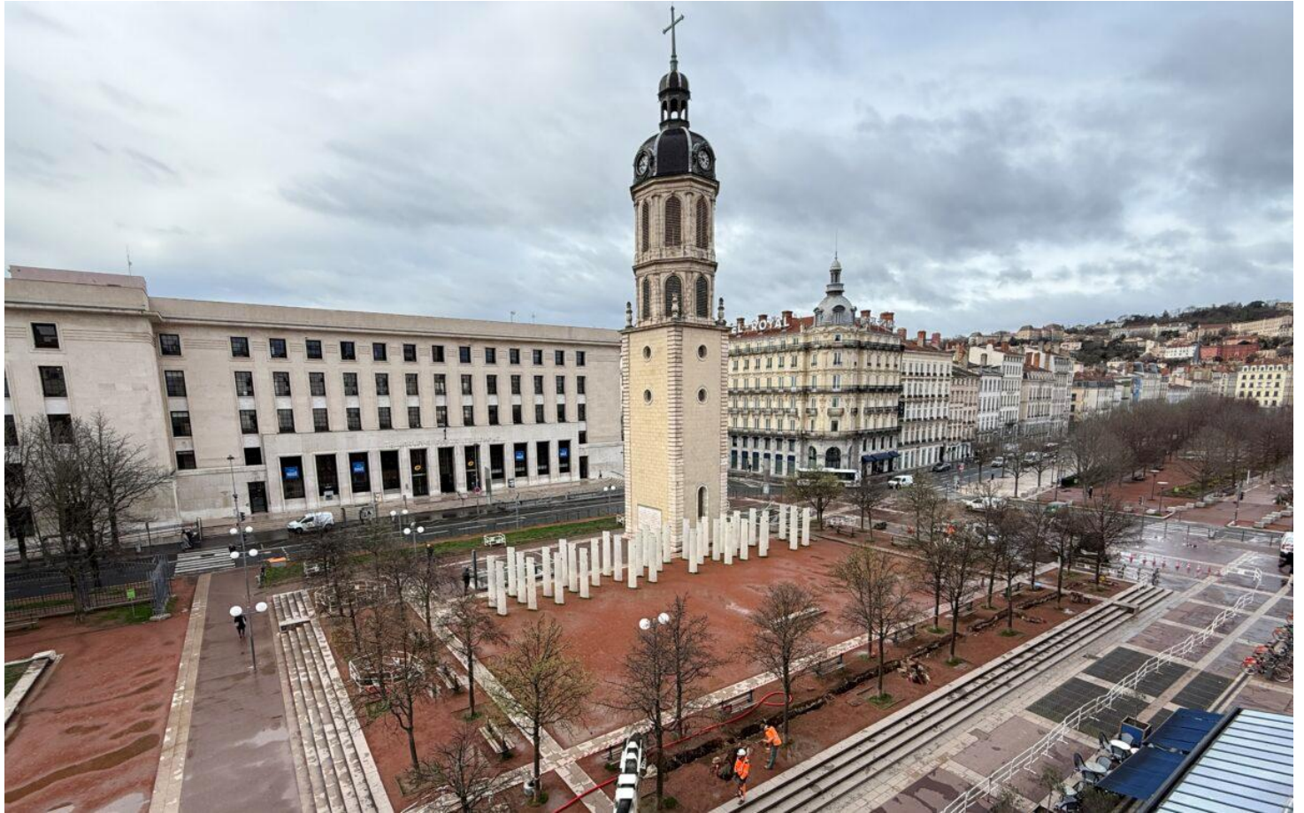
Travaux place Antonin Poncet, pour l'installation d'un nouvel éclairage public. ©Veronique Lopes
