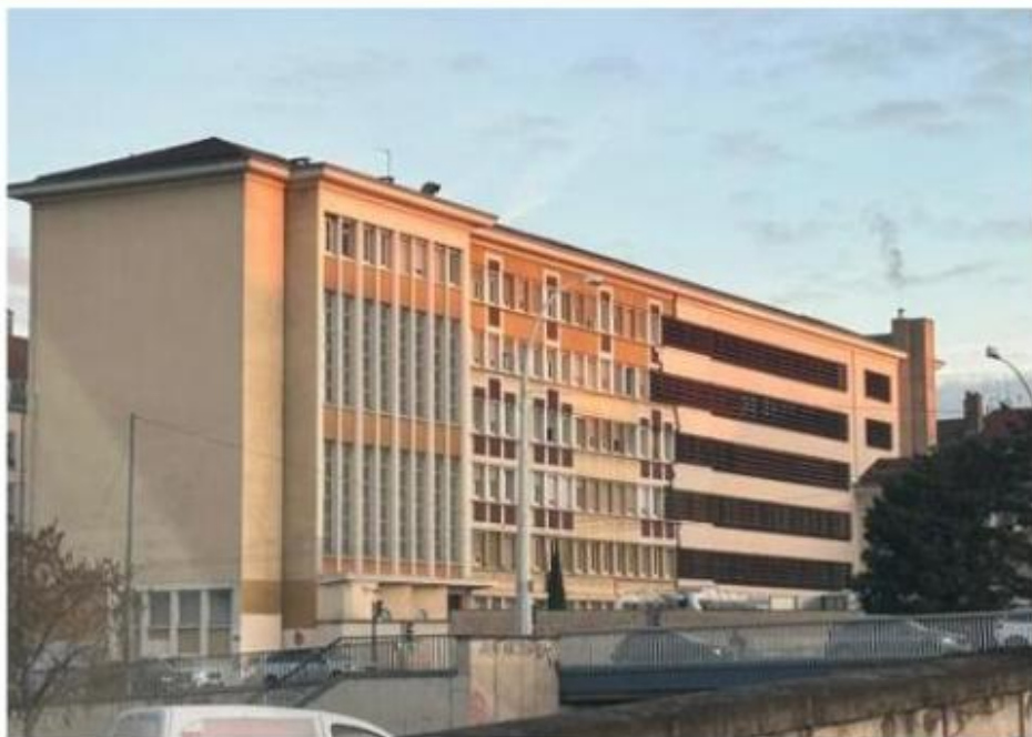
La façade du lycée en cours de rénovation avec une partie renouvelée et l'autre pas encore. Photo M. T.
