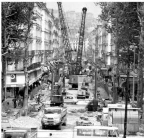
L'état de la Rue de la République en mai 1974. Plus rien ne passe si ce n'est les engins de chantier. Archives Le Progrès
