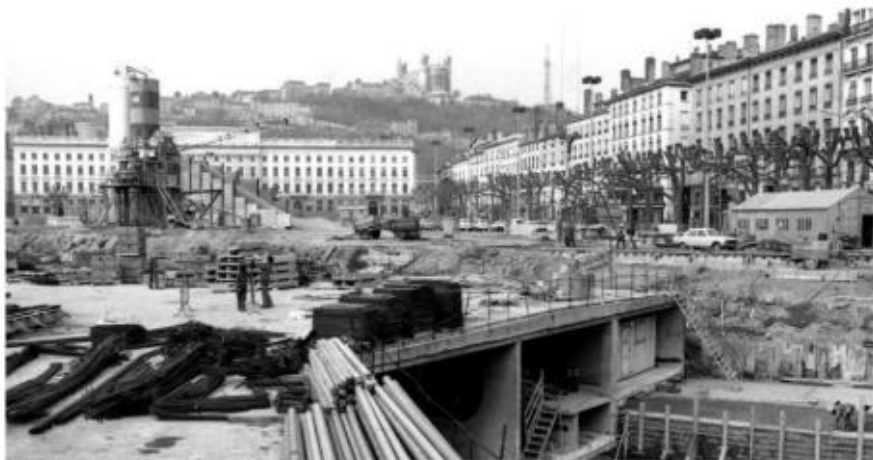
Lyon construit son métro. Et place Bellecour, totalement éventrée par le chantier, l'heure n'est pas encore à la fête des lumières. Archives Le Progrès
