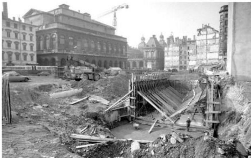
Place Louis Pradel, des démolitions d'immeubles seront même nécessaires. Bien visibles sur cette image datée de février 1976. Archives Le Progrès
