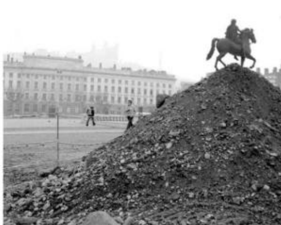
Depuis 1973, la ville est sens dessus-dessous et Louis XIV domine un immense chantier. Archives Le Progrès
