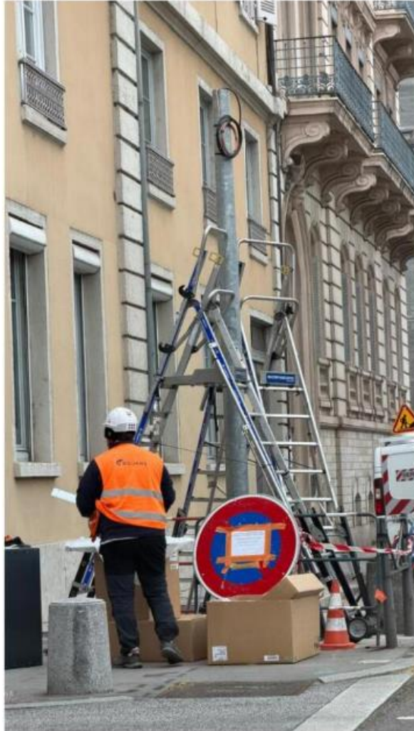
Le radar fixe est en cours d'installation. Photo fournie
