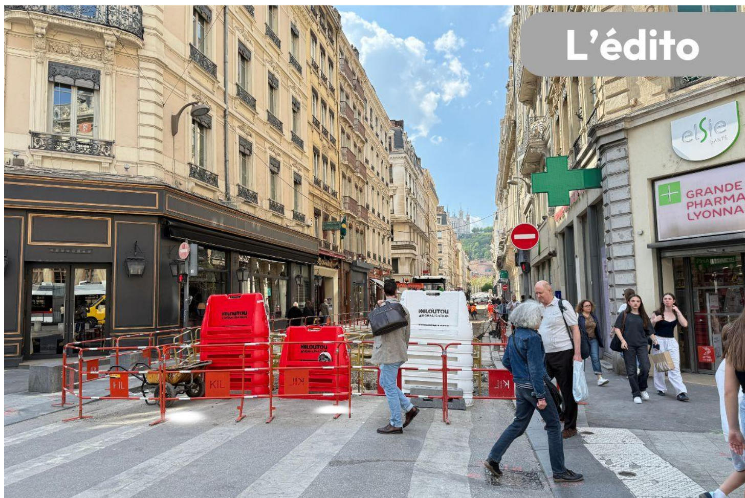
La rue Grenette en travaux (illustration). © Véronique Lopes
