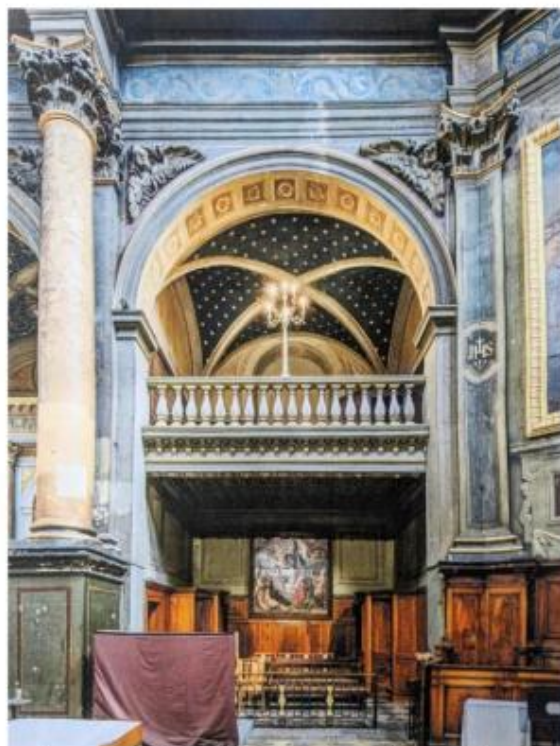
Le transept nord, à son tour rénové ; son inauguration a donné l'occasion d'un appel aux dons pour poursuivre le chantier. Photo Sylvie Silvestre
