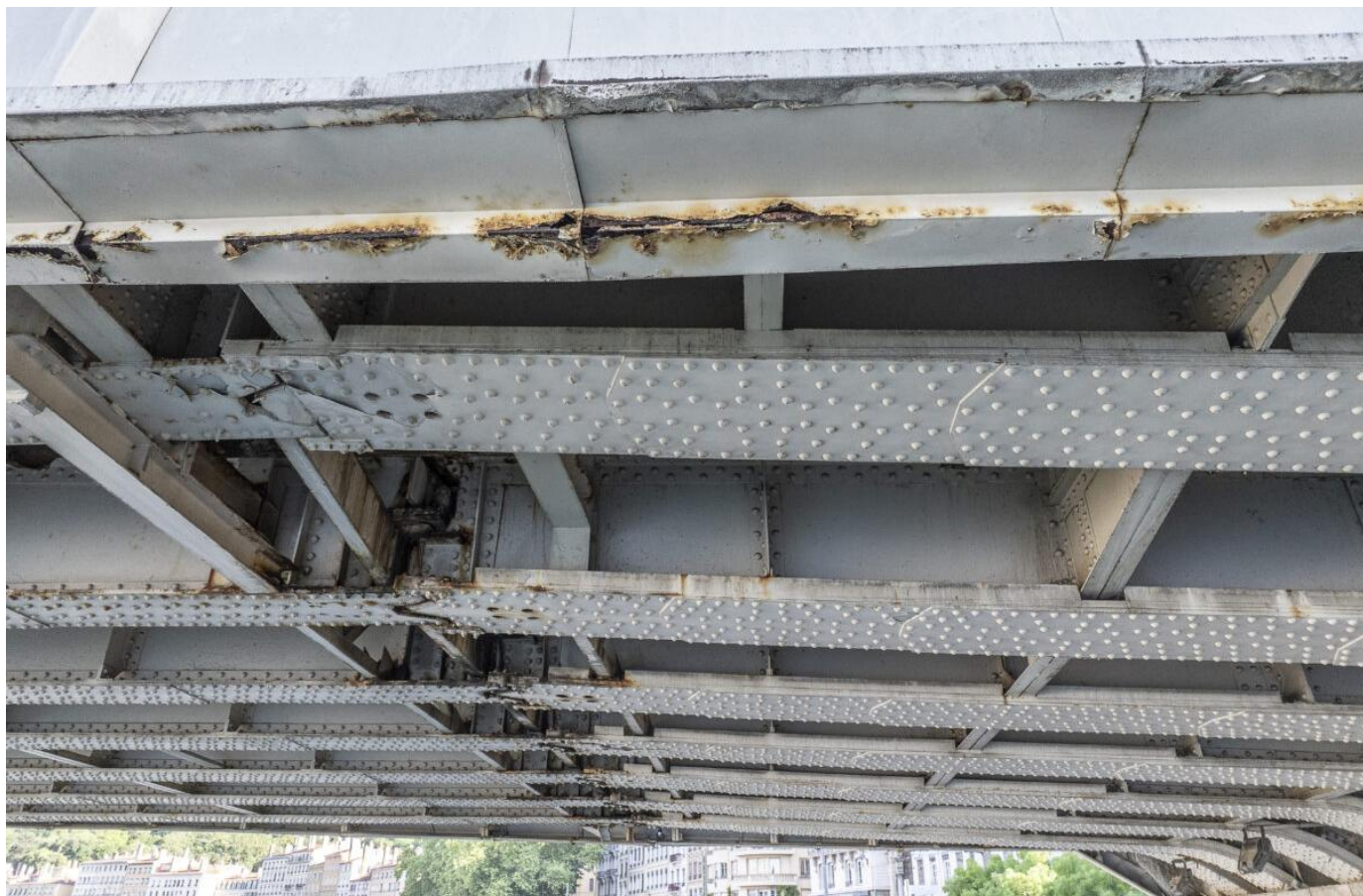
Pont de la Feuillée à Lyon : corrosion de certaines parties de la charpente métallique. (@Métropole de Lyon)
