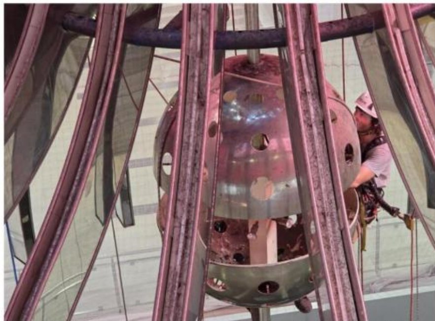
Le démontage a démarré il y a deux jours. Tout se passe à une dizaine de mètres de hauteur.
