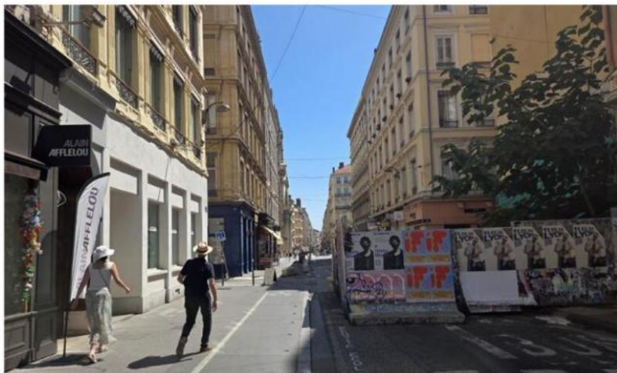
Dans la rue Paul-Chenavard, des palissades soutenues par des blocs de béton entourent toujours l'immeuble condamné. Photo Régis Barnes
