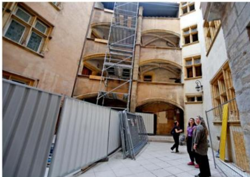
La cour intérieure du musée de l'Imprimerie est en proie à d'impressionnants chantiers.
