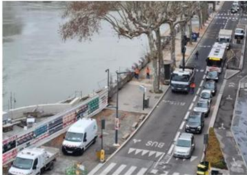
Le quai Saint-Antoine a connu de multiples chantiers ces dernières années. Comme ici en décembre 2024 où la circulation automobile reste très difficile. Photo Aline Duret
