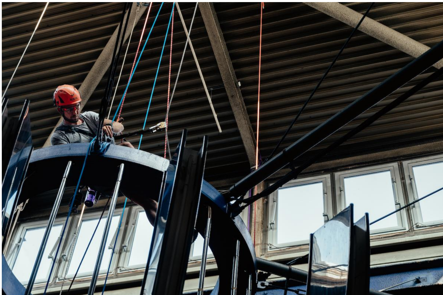
Démontage du lustre du centre d'échanges de Lyon-Perrache – 16 juillet 2026. © Matthieu Delaty
