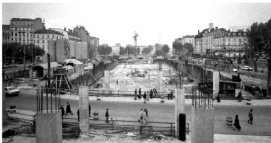
16 mai 1973. Les fondations sont presque achevées. La construction du paquebot de béton va bientôt débuter à l'emplacement du Cours de Verdun. Photo d'archives Le Progrès
