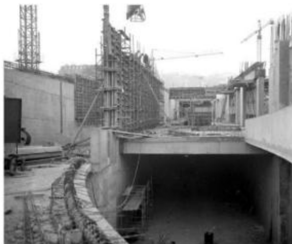
L'ouvrage est édifié au-dessus d'un nœud routier et de sept trémies routières. Photo d'archives Le Progrès
