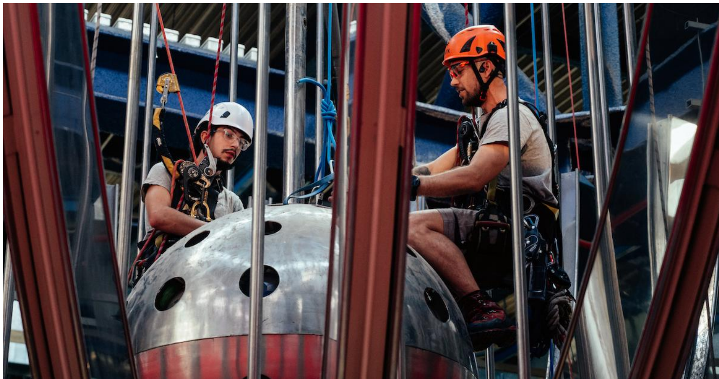
Démontage du lustre du centre d'échanges de Lyon-Perrache – 16 juillet 2026. © Matthieu Delaty
