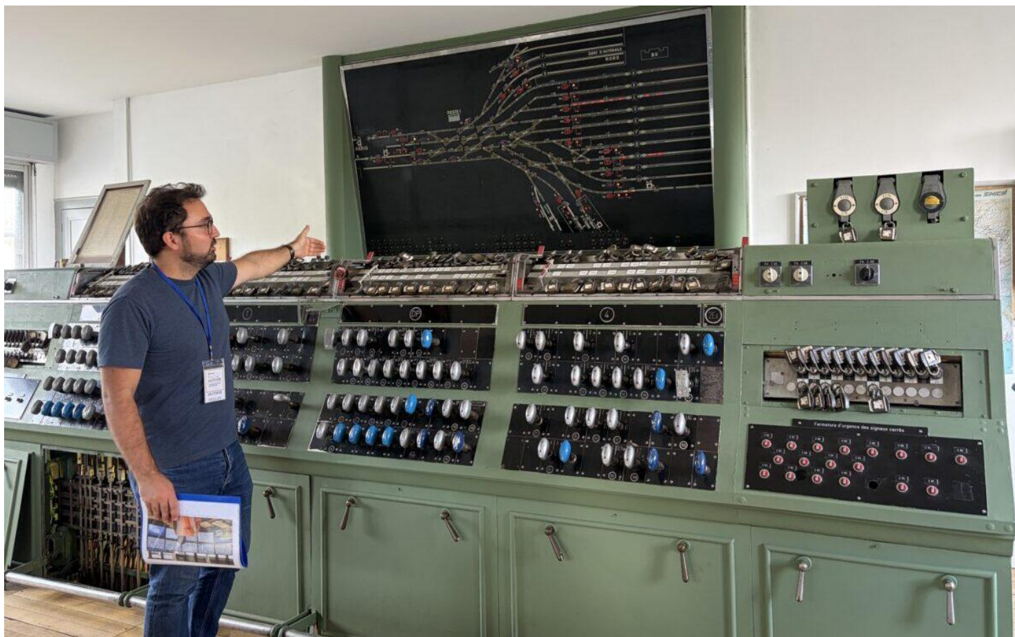
Olivier Vellay, Architecte du Patrimoine devant le Poste d'aiguillage n°1 de Perrache (CM)
