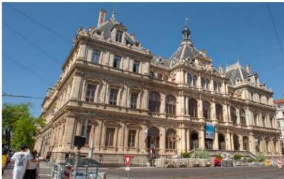
Ce nouveau salon se tiendra au Palais de la Bourse.
