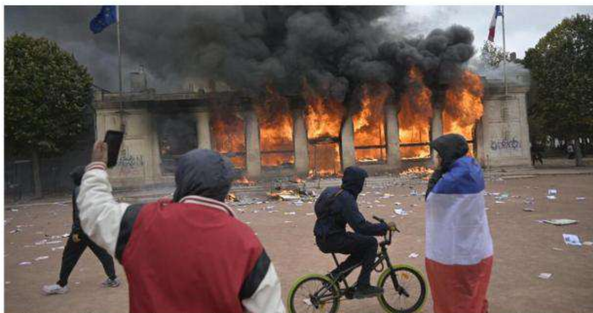
Le bâtiment de l'Office de tourisme, situé place Bellecour, à Lyon, a été détruit par des casseurs qui l'ont volontairement incendié ce samedi 17 octobre. Photo Maxime Jegat
